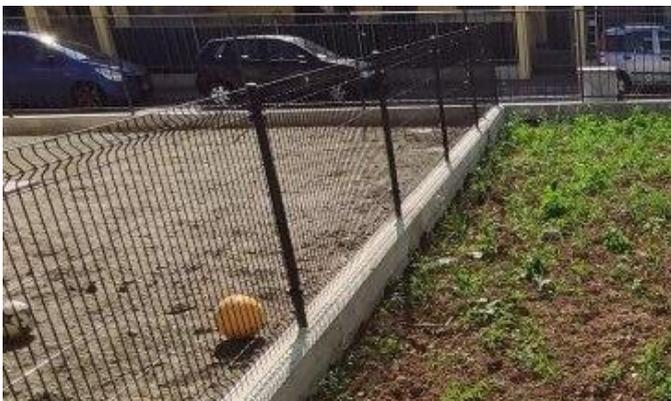
Avrà un'altezza di 100-120 cm. Sarà realizzata con rete metallica plastificata, tesata su paletti d'acciaio plastificati, posti in opera con interasse di circa 1,50 m. Con riferimento alle quote del terreno, la D.L. potrà definire, nel limite di quelle sopraindicate, altezze diverse della recinzione.
