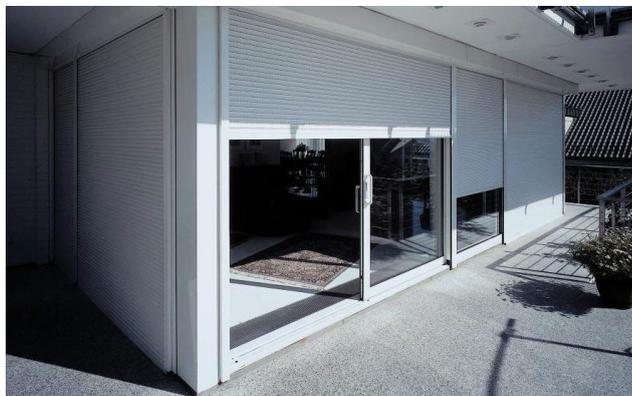
Dove indicato dal progetto i sistemi oscuranti saranno realizzati con tapparelle avvolgibili in alluminio prevista installazione per finestre e porte finestre poste ai piani terra, primo e secondo, con larghezza inferiore a mt. 2,50, il colore sarà a scelta della D.L. di un colore chiaro.
